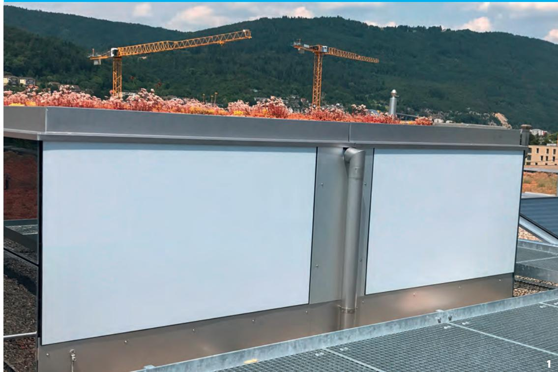
**1** Cette intégration de panneaux photovoltaïques blancs de la société **Solaxess** a été réalisée à des fins de démonstration au Jardin des énergies de l'ESB (Energie Service Bienné).
