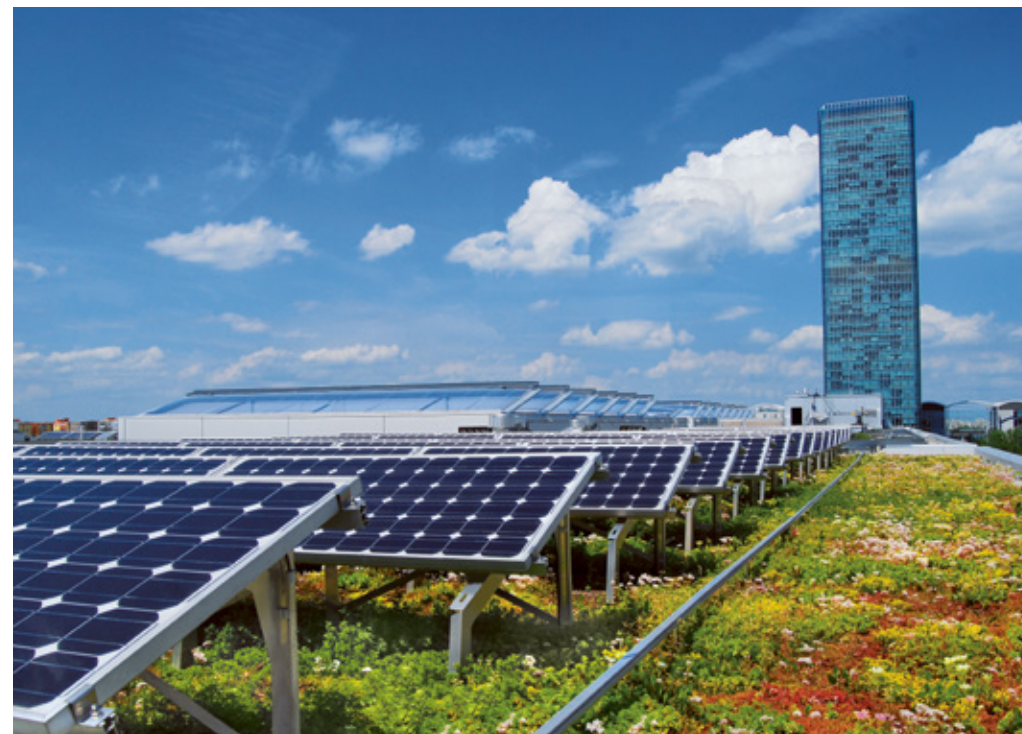
Kombineerides mätaskatuseid päikesepaneelidega, on võimalik vähendada hoone kütte- ning jahutuskulusid. Kui selliseid katuseid kasutada kõikidel hoonetel, on võimalik päikeselistes piirkondades alandada terve kvartali temperatuuri. Pildil on ZinCo süsteem, milles kombineeritakse mätaskatused päikesepaneelidega. Autor: ZinCo GmbH
