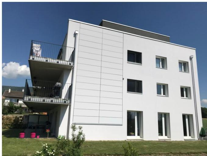
Image de gauche : Première réalisation sur un bâtiment existant avec des modules PV utilisant des films blancs Solaxess (Boudry, Suisse).
