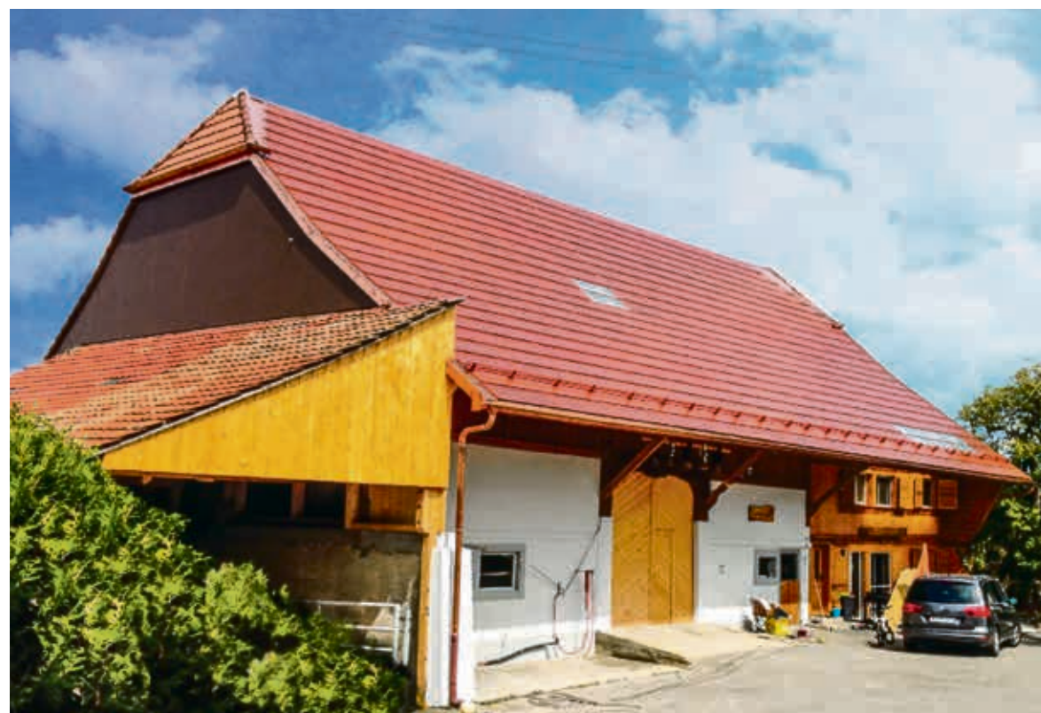
Camouflé : les briques de cette ferme construite en 1859 à Ecuwillens (FR) ont tout pour plaire : ce sont des modules PV spécialement développés pour les bâtiments classés.
