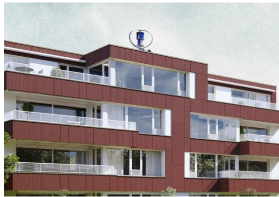
Das Windrad liefert die Energie für den effizienten Personenlift von Schindler
