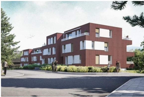
CO 2 -neutrale Wohnüberbauung Männedorf: Mit weissen und dunklen Solarzellen
