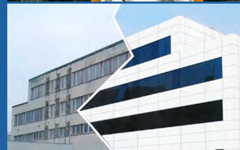
renové et actif
