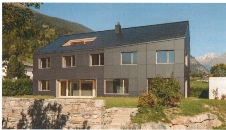
La maison à énergie positive d'hiver Sol'CH située à Poschiavo (GR) est un exemple parfait, et primé, d'installation photovoltaïque intégrée. L'ensemble de l'enveloppe du bâtiment, façade nord comprise, est composé de panneaux photovoltaïques. Photo: Nadia Vantobel Architekten GmbH
