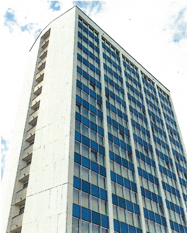
Rénovation de la Tour Firmenich, Genève.
